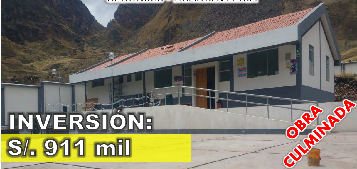
CONSTRUCCIÓN DEL PUESTO DE SALUD SAN GERÓNIMO - HUANCAMELICA
